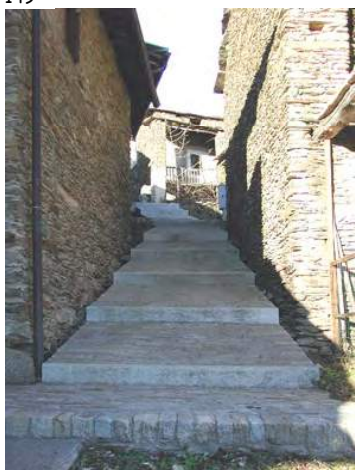
149. percorso esterno sistemato con rampa in pietra: da notare lo stacco dalle murature laterali sistemato a canaletta per il deflusso dell'acqua
