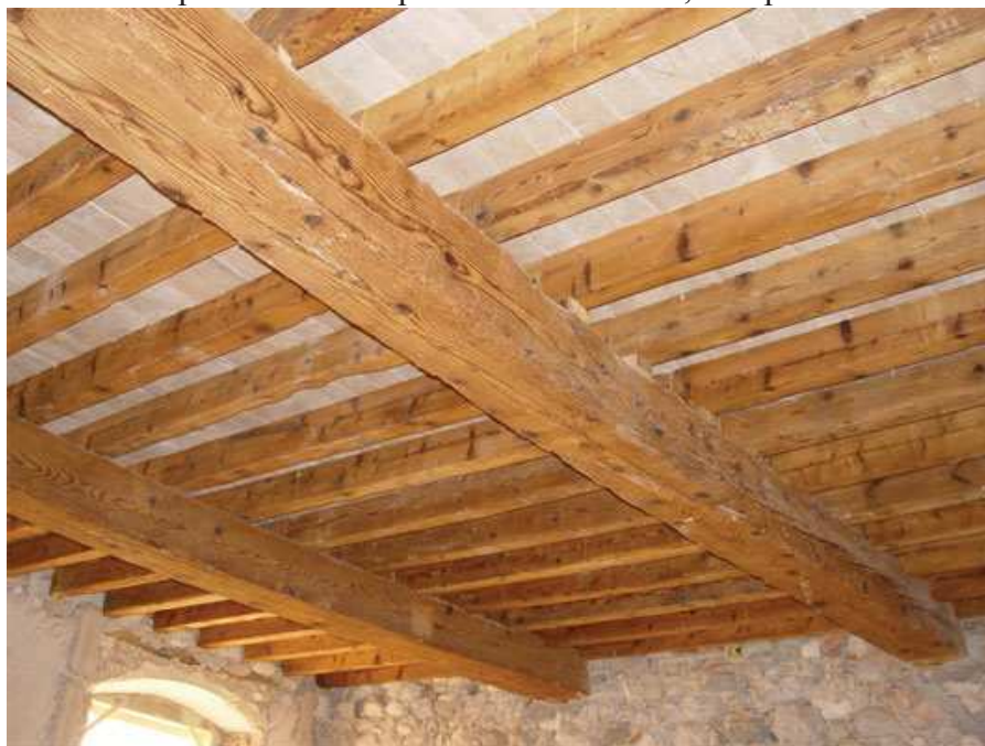
Solaio piano con struttura in legno
