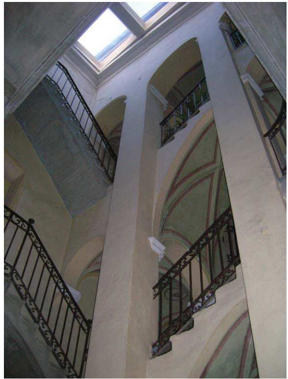
Palazzo Borelli, la scala rampante
