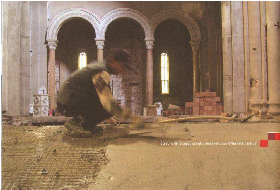
Cantiere del Sacro Cuore, Cuneo- consolidamento delle volte con rete in acciaio e teli di carbonio
