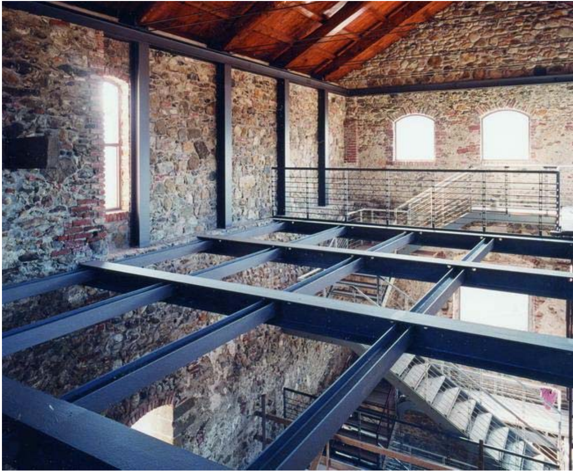
Marco Ciarlo - Scala interna in acciaio del castello di Millesimo
