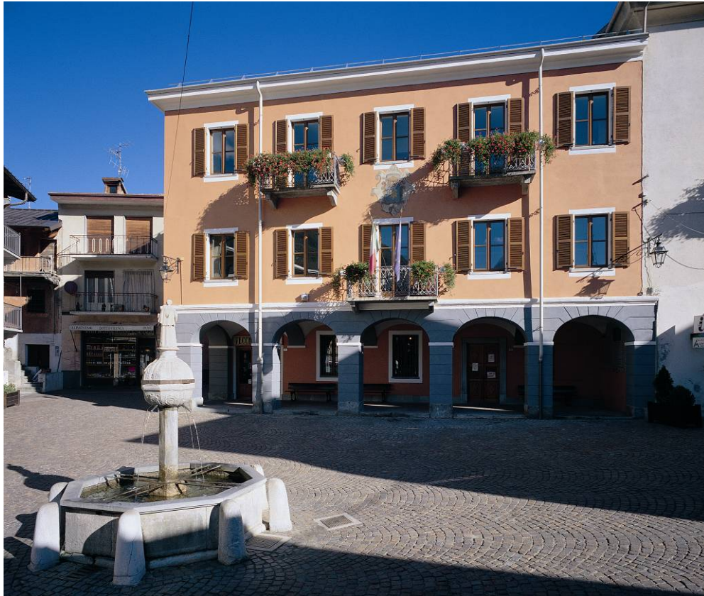
Municipio di Entracque – recupero dell’edificio con inserimenti in legno, acciaio e vetro, sul fronte verso corte
