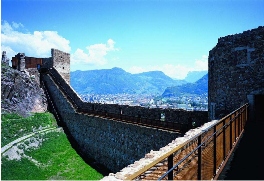
Werner Tscholl: Castel Firmiano, Bolzano – vista esterna
