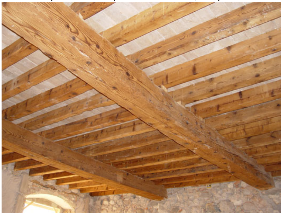
Solaio piano con struttura in legno
