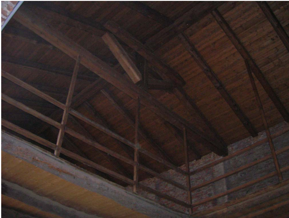
Palazzo Giriodi Costigliole Saluzzo – copertura legno a vista, capriata, arcarecci, tavolato
