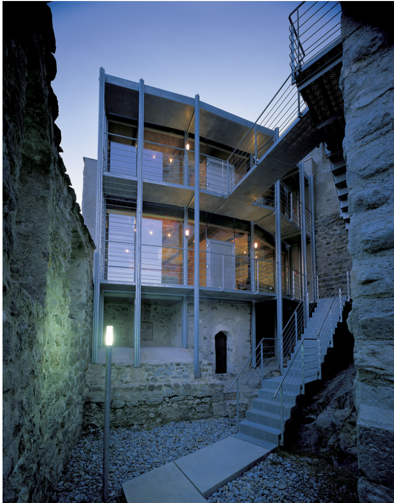
Werner Tscholl: Ristrutturazione e ampliamento della Scuola professionale per l'agricoltura "Fürstenburg" a Burgusio
